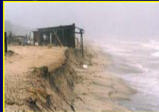
夜見・富益工区の船小屋流出 (平成10年9月)
