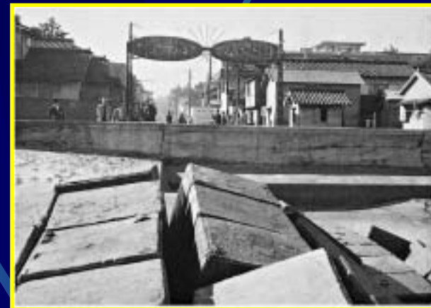
日吉津突堤災害状況 (昭和36年)
