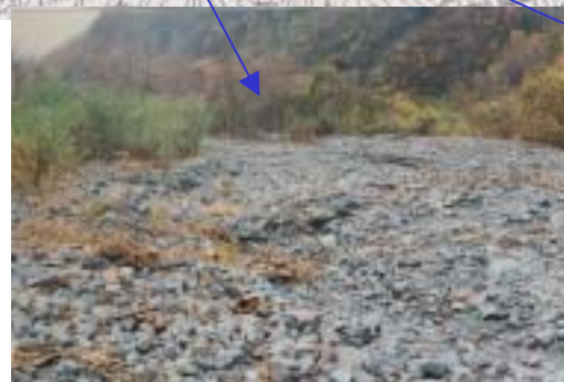
未鎌砂防えん堤付近の土砂堆積状況
