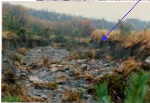
下流河道部での侵食状況
