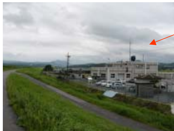
県企業局工業用水配水施設
