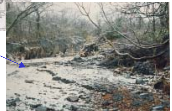
河道部での土石流の流下状況
