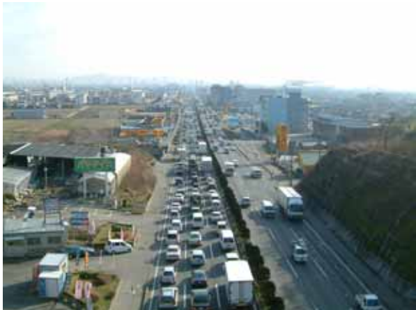
一般国道2号西方から岡山市方面を望む
