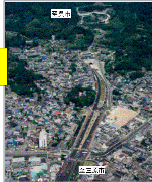
休山改良(阿賀方面より呉方面を望む)
