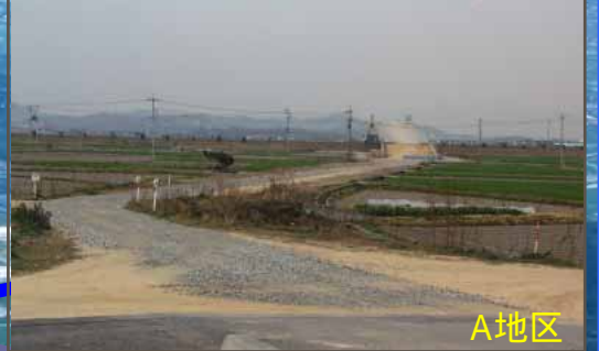
市道施工状況
