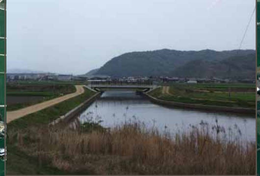
永江川 (県区間) 改修状況
