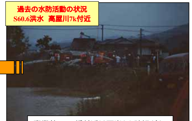
事業前のJR橋付近は両岸とも踏切があり、天端も狭く水防上、点検や実作業に支障有り
