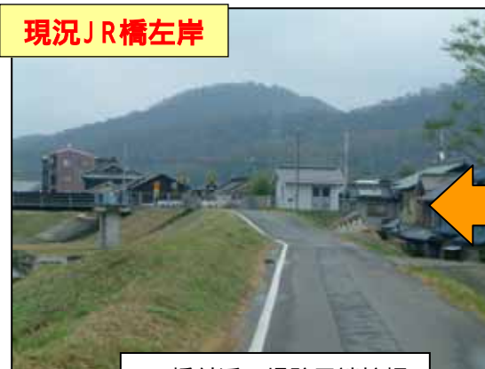
JR橋付近の堤防天端拡幅
