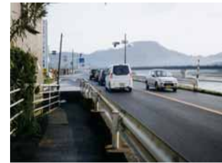
供用後の状況（袋河原交差点）
