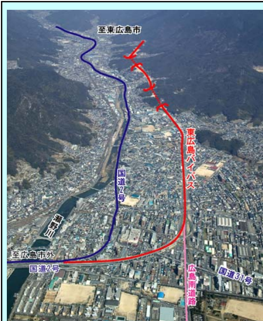
① 終点（海田町）からの本路線を眺める （上空斜め写真）
