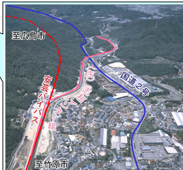
① 起点側 (東広島市八本松町) から本路線を眺める (上空斜め写真)
