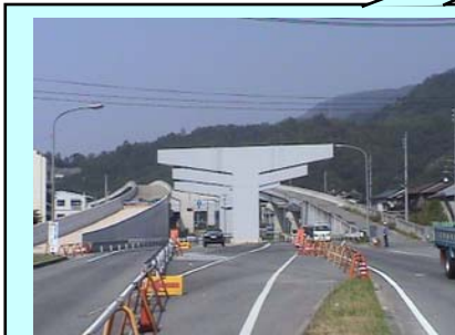
②海田東ランプ部（海田町）
