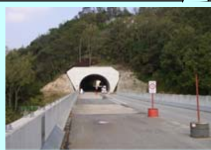
③曾田高架橋（広島市安芸区）
