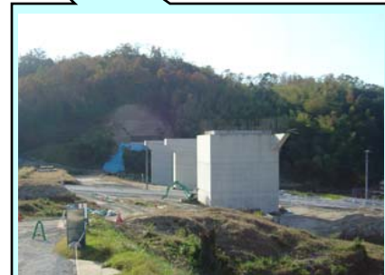
⑤押手高架橋（広島市安芸区）
