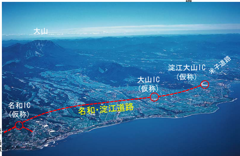
(写真①日本海より大山方向を望む)
