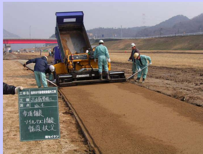
現地発生土舗装の状況
