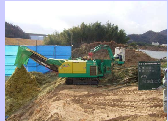
チップ化の作業状況
