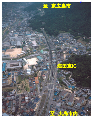
①東広島バイパス 海田東IC付近から部分供用区間を望む
