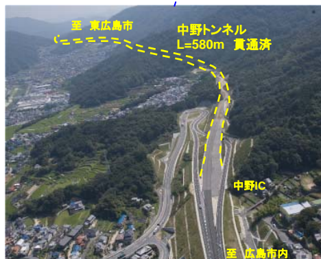
②東広島バイパス 中野IC付近から東広島市方向を望む
