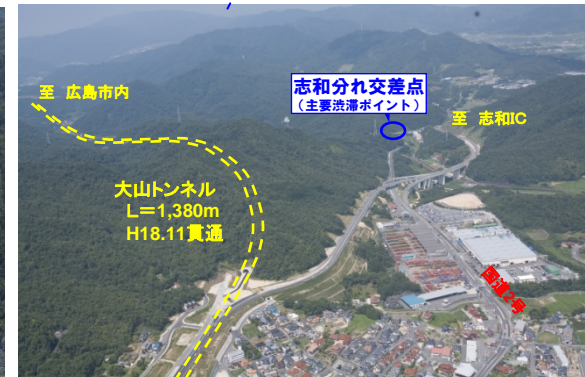
④安芸バイパス バイパス起点側から広島市内方向を望む
