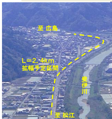
①三刀屋拡幅(L=2.4km区間) L=2.4km起点付近から広島方面を望む
