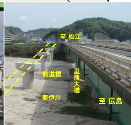
④三刀屋拡幅(L=1.0km区間) 里熊大橋南側から松江方面を望む
