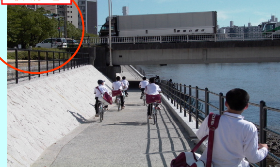
北大橋のアンダーパスと横断歩道
