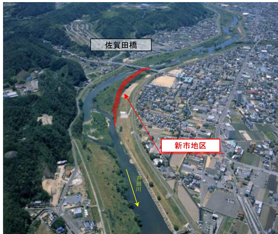
▲親水護岸整備所
