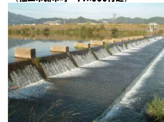
▲遡上降下を妨げている横断工作物 (府中市高木町 26k300付近)
