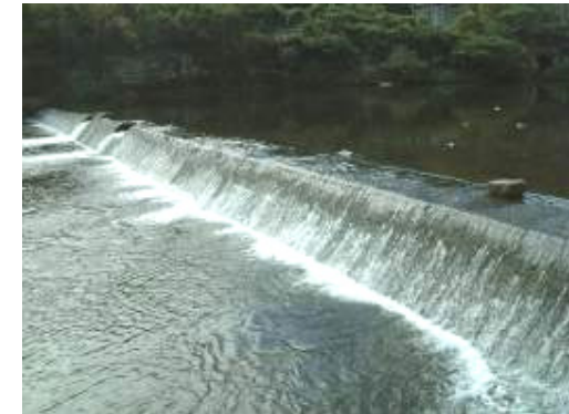
▲落差の大きい堰（①大井手頭首工）
