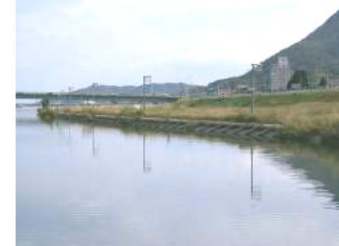
▲試験施工実施前
