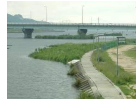
▲試験施工実施後
