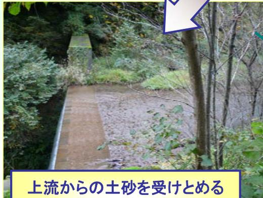
上流からの土砂を受けとめる西鴨谷川第2砂防堰堤(満砂)
