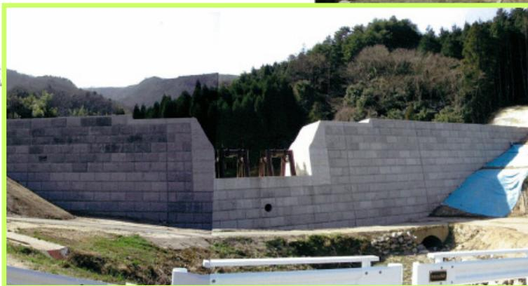
ダブルウォール工法を採用した大河原砂防堰堤 (H15竣工)
