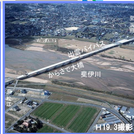
④ からさで大橋付近
