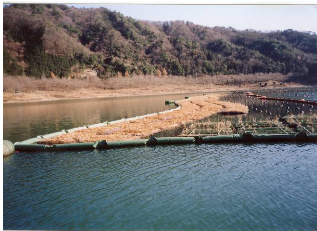
浮島・人工生態礁の状況
