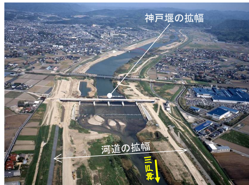
神戸川(拡幅部7.5km付近)(平成20年5月)
