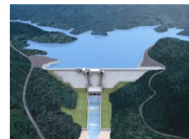
①-1 尾原ダム
