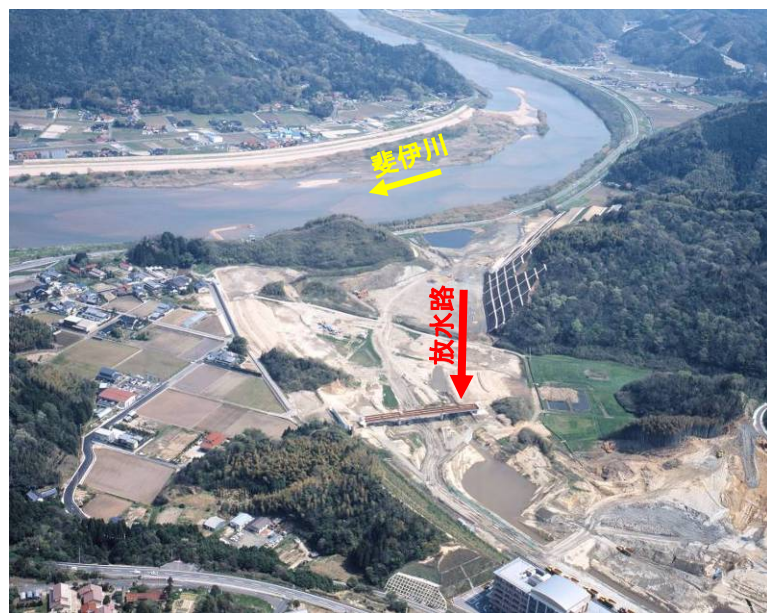
斐伊川放水路(開削部分流点付近)(平成20年5月)
