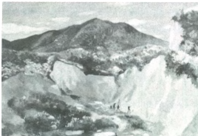
地山の掘削状況
