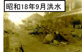
昭和18年9月洪水による益田市街地の被災状況
