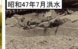
昭和47年7月洪水による派川虫追橋の被災状況
