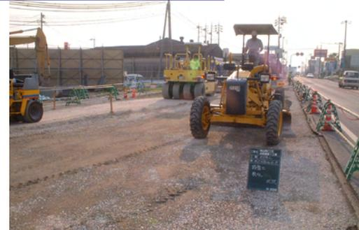
切土工事により発生する岩塊を現場内で破碎（クラッシング）し、路盤材料として再利用することにより、路盤材購入費を縮減。
