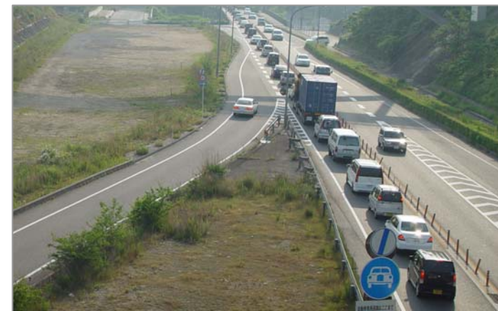
①松本トンネル西抗口手前付近 (福山市方向を望む)
