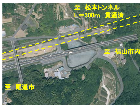
② 松本トンネル付近
