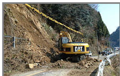
土砂崩れによる通行止め (国道373号 智頭町福原地区)
