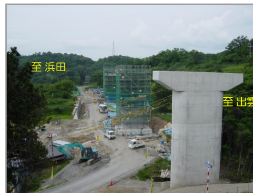
②馬路第1高架下部第1工事状況 出雲方面から浜田方面を望む
