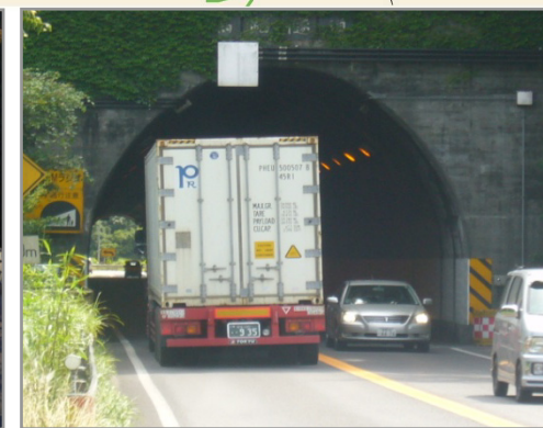
② 背高海上コンテナ輸送車通行支障トンネル(馬路トンネル)
