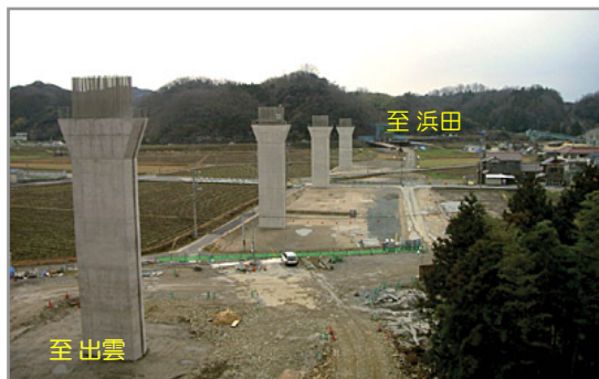
①福波第2高架橋下部工事状況 福光付近から浜田方面を望む
