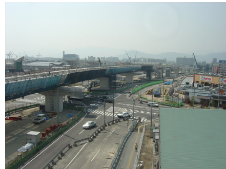
【②広島みなと公園付近の進捗状況】
