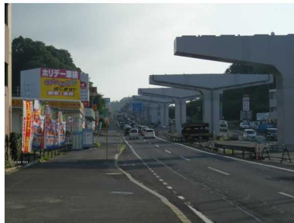
廿日市高架橋（宮内交差点付近）の工事の様子
