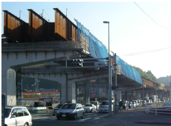
廿日市高架橋（速谷交差点付近）の工事の様子
