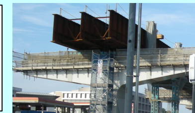
廿日市高架（速谷交差点付近）の施工状況
