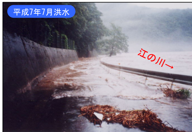
国道375号冠水による避難路途絶
