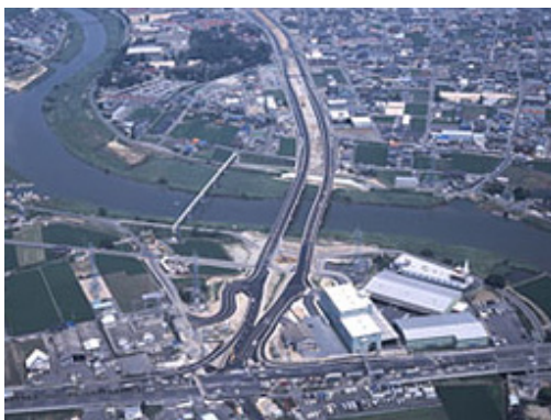
【写真①】供用済み箇所(古新田から北方面を望む)
