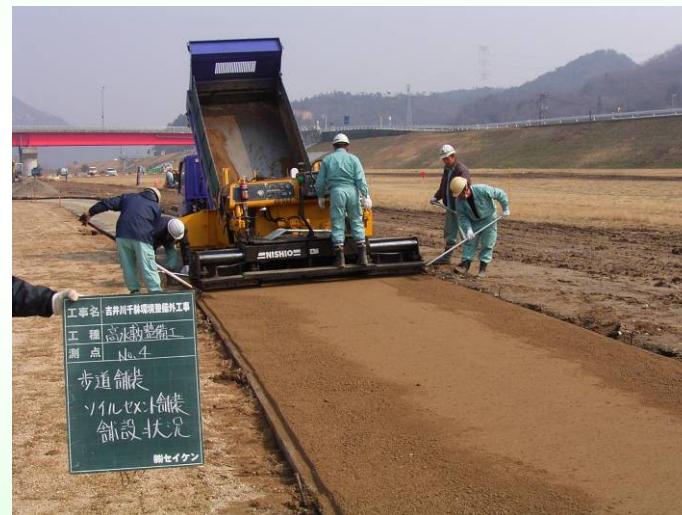
現地発生土舗装の状況
