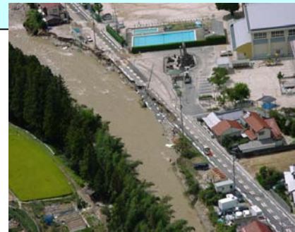
上流支川玖島川友和地区の河岸洗掘
