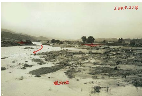
昭和34年9月伊勢湾台風洪水 倉吉市関金地区の破堤状況
