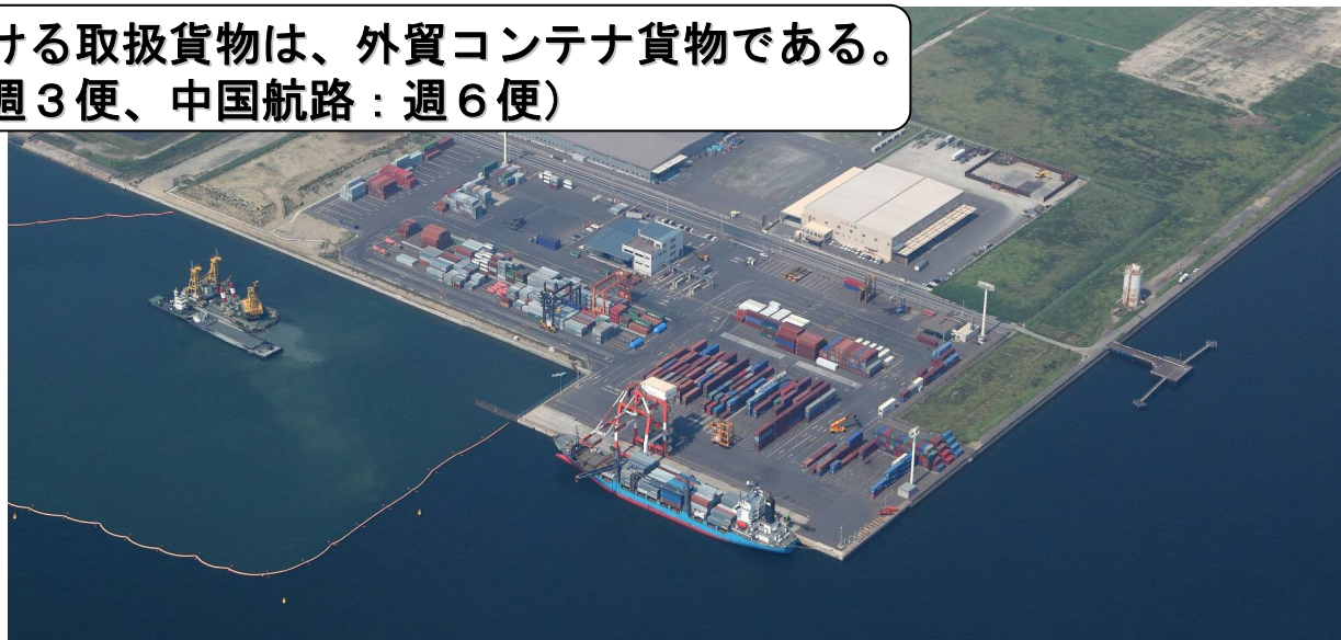
船舶接岸状況遠景
