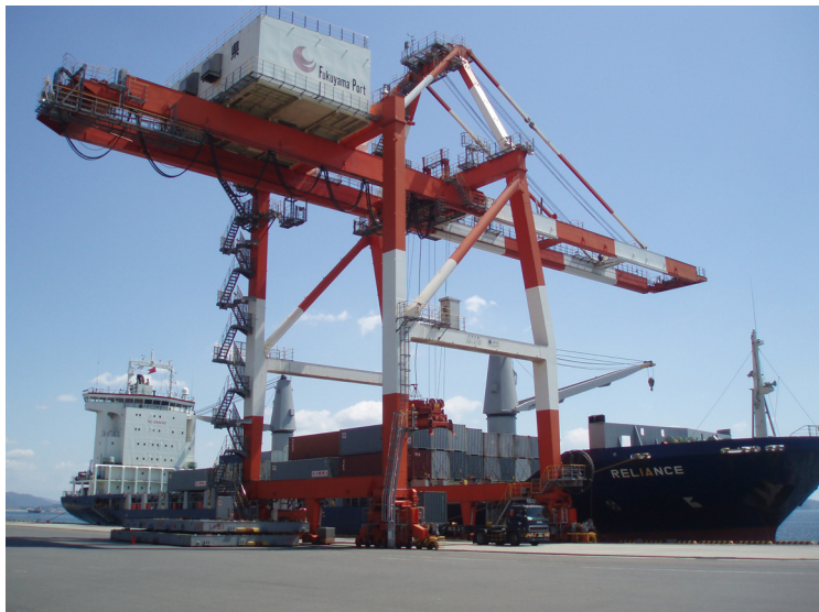
荷役機械利用状況
