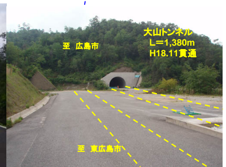
⑤安芸バイパス 八本松IC(仮称)から大山トンネルを望む
