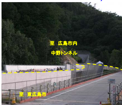
②東広島バイパス 中野東IC(仮称)付近から中野トンネルを望む(床板施工中)
