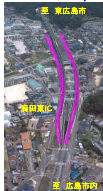
①東広島バイパス 海田東IC付近から部分供用区間を望む
