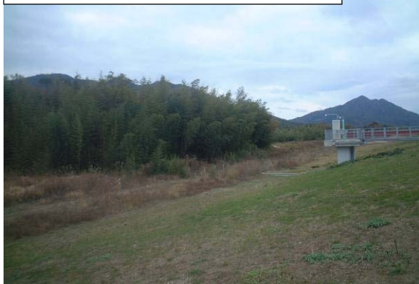
完成前の状況 平成 17 年度撮影
