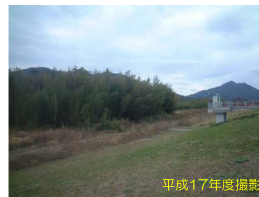
完成前の状況
