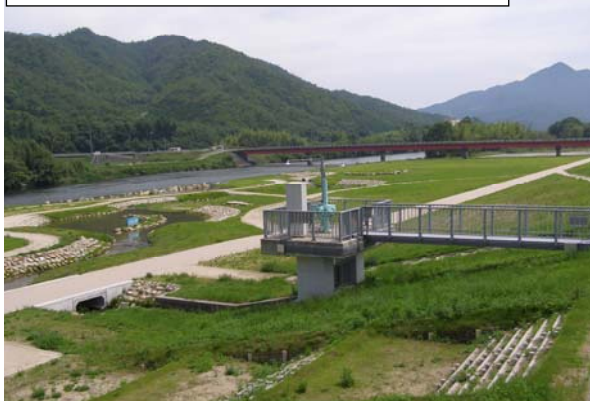
完成後の状況 平成 19 年度完成
