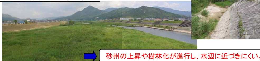
現在の「佐波川（新橋地区）」の状況
