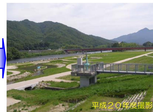
完成後の状況
