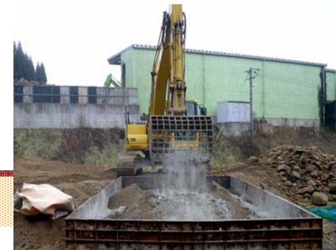
現地発生土とセメントの攪拌状況
