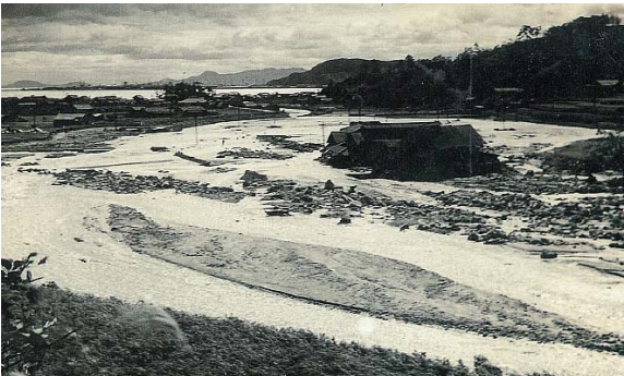
土石流で被災した集落（大竹市玖波町）
