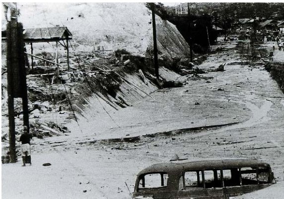
大野陸軍病院の患者用車が流され、国鉄山陽線軌道が土砂で埋没（廿日市市（旧大野町））
