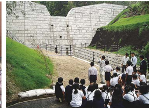
砂防堰堤の見学会で施設の役割を説明
