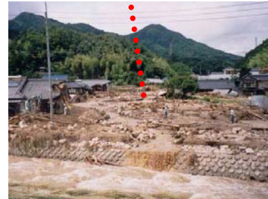
このかわ 古野川の土石流氾濫状況
