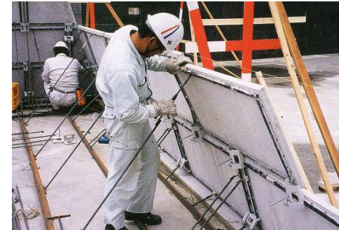
残存型枠施工状況
