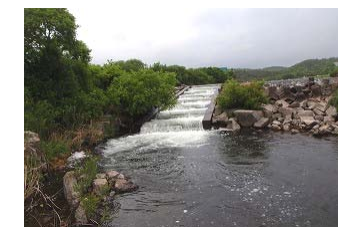
魚道現況(笠井堰)
