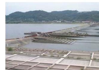
魚道現況(潮止堰)
