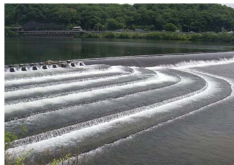
高梁川合同堰(湛井堰)魚道
