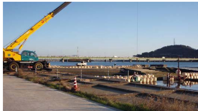
【現地での大型土のう設置状況】
