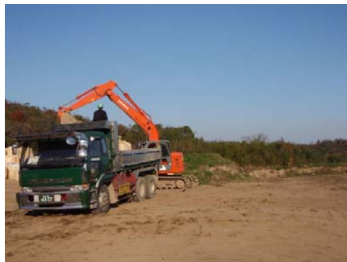
【仮置き場からの搬出状況】
