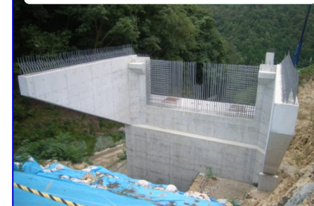
写真④ 下部工施工状況（小浜第1高架橋）
