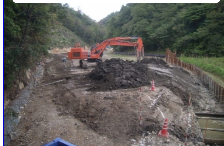
写真⑦ 地盤改良工施工状況（福光地区）
