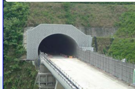
写真② トンネル施工状況（天河内第1トンネル）
