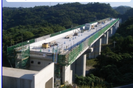
写真③ 上部工施工状況（馬路第1高架橋）
