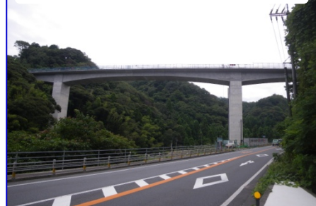
写真⑥ 小浜第3高架橋の上部工部分
