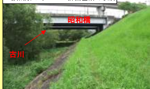
昭和橋アンダーパス計画箇所の状況
