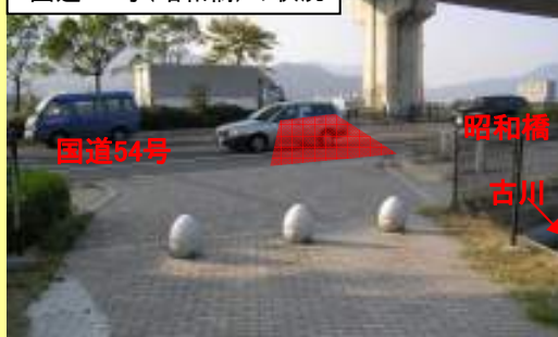
国道54号(昭和橋)の状況
