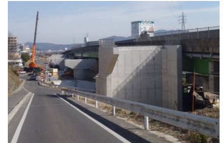
写真③津高大橋の工事進捗状況
