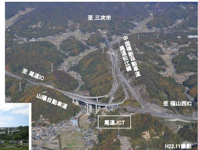
【写真①】尾道JCTを南より望む
