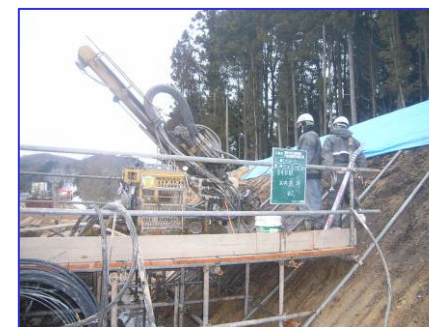
アンカー工施工状況
