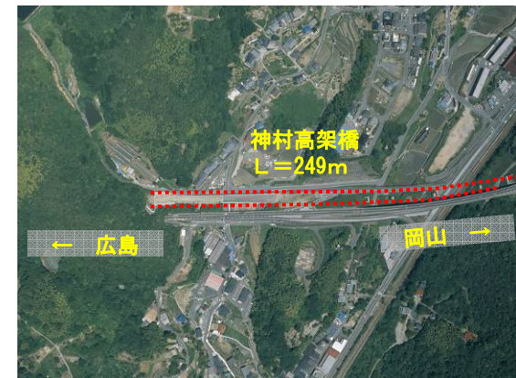
【写真③】神村ランプ付近上空から空撮 (事業中区間の状況)
