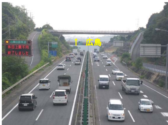
【写真①】今津ランプ付近から尾道方面を望む (4/4供用済み区間)
