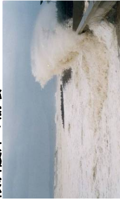
①-1 皆生地区; 強波浪による緩傾斜護岸の崩壊
