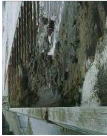
①-1 皆生地区; 強波浪による緩傾斜護岸の崩壊
