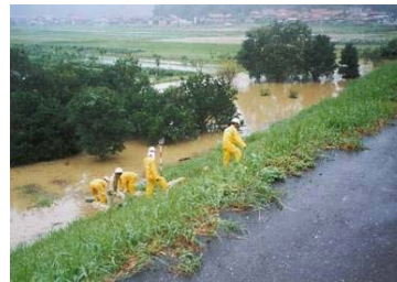
⑤ 平成9年7月洪水による堤防法尻からの漏水対策のための水防活動状況
