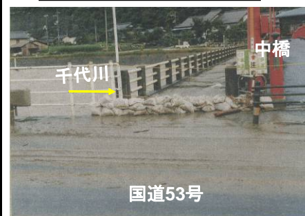
鳥取市用瀬地区の増水状況
