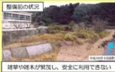
整備前の状況 雑草や雑木が繁茂し、安全に利用できない
