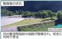
整備後の状況 河川管理用階段や坂路が整備され、安全に利用できる
