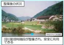
河川管理用階段が整備され、安全に利用できる
