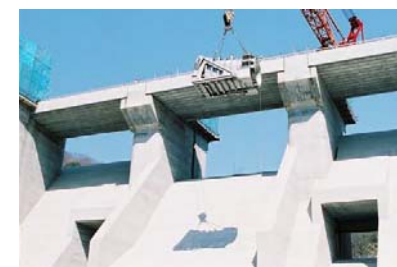
▲灰塚ダム建設工事の状況
