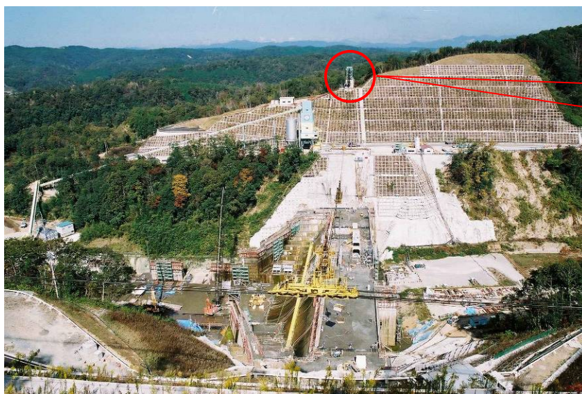
灰塚ダムコンクリート打設状況(H15.10)
