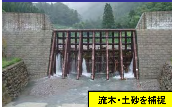
小泉2号砂防堰堤の捕捉状況
