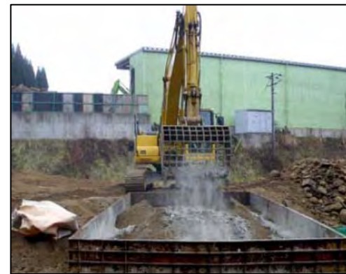
現地発生土とセメントの攪拌状況
