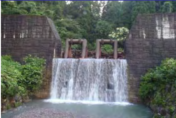
福原2号砂防堰堤の捕捉状況
