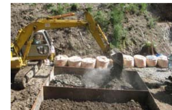
ソイルセメント攪拌状況
