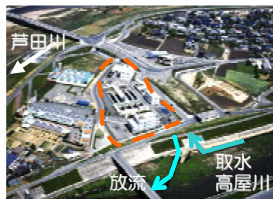
高屋川河川浄化施設
