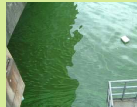
河口堰湛水区間のアオコの発生状況 (芦田川河口堰ゲート付近)
