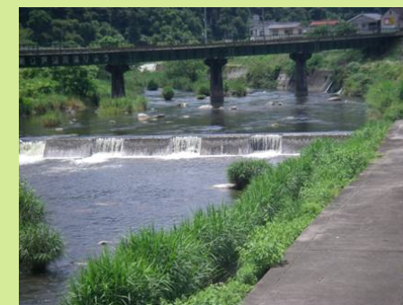
遡上降下を妨げている横断構造物 (40k390付近[南坊井堰])
