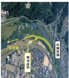
▲護岸整備箇所
