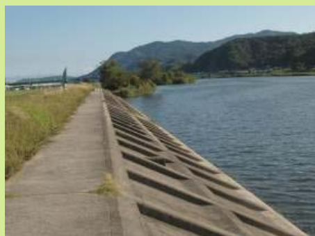
植生がない護岸 (6k400付近)
