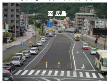
<写真②：暫定供用区間>
