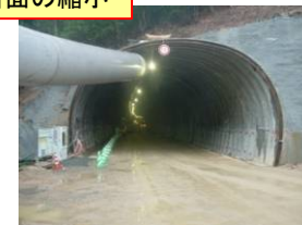
大林トンネル：施工状況写真
